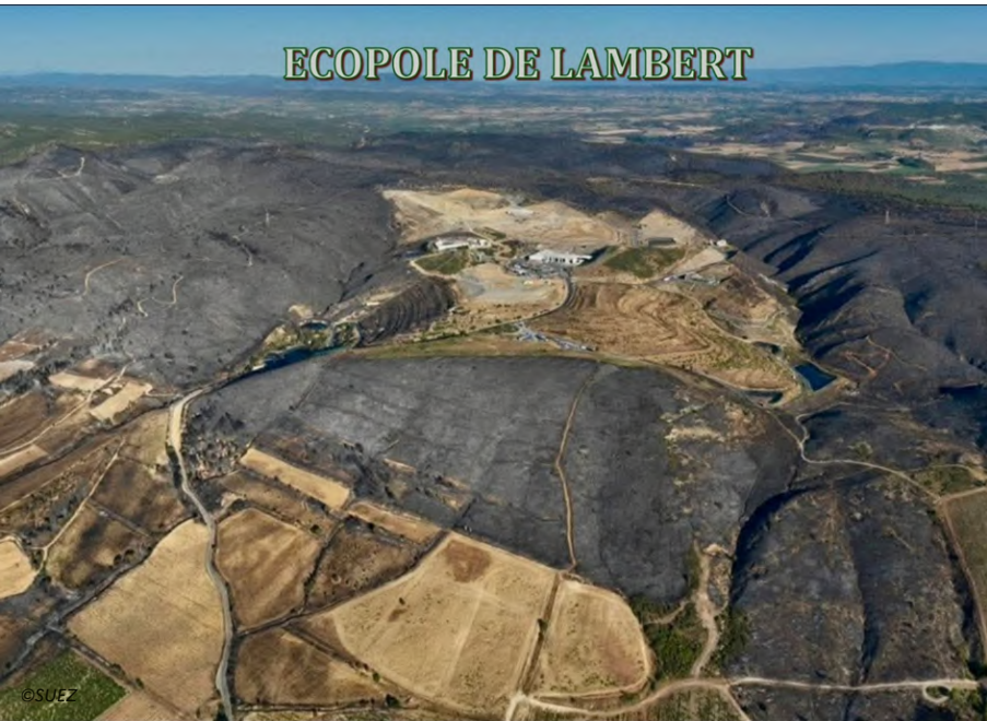
Vue aérienne du site après l'incendie
