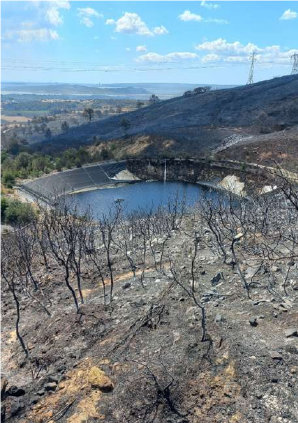
Dégât sur le bassin de rétention des eaux pluviales
