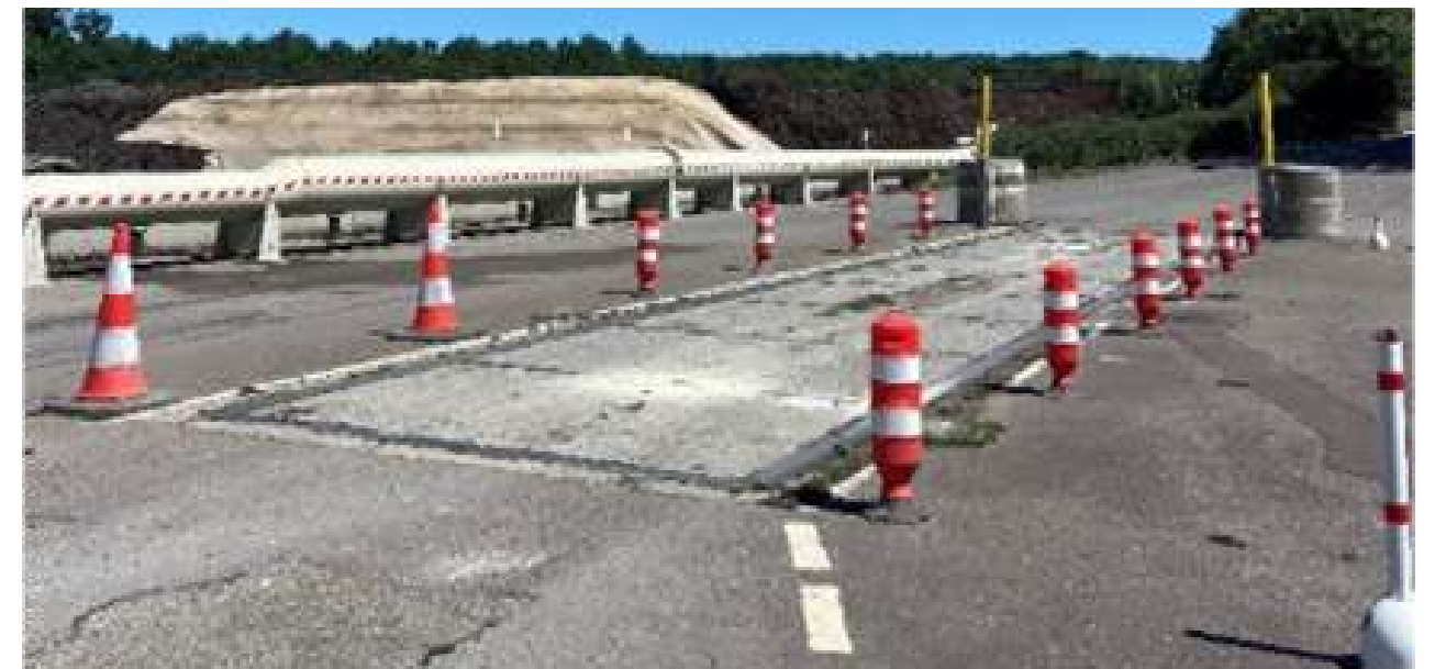
Exemple d'un pont bascule sur un centre de méthanisation/compostage (©SUEZ / Pauline Dupont)
