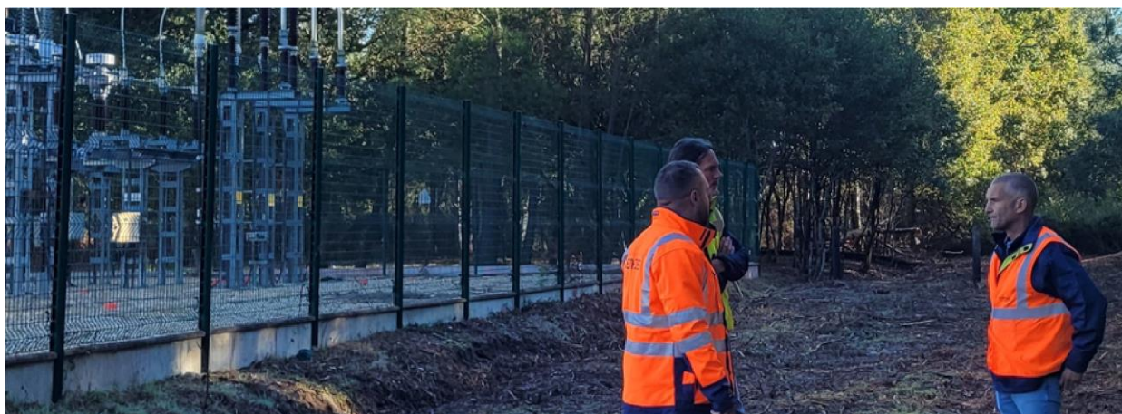
Premier poste électrique débroussaillé à Lacanau
